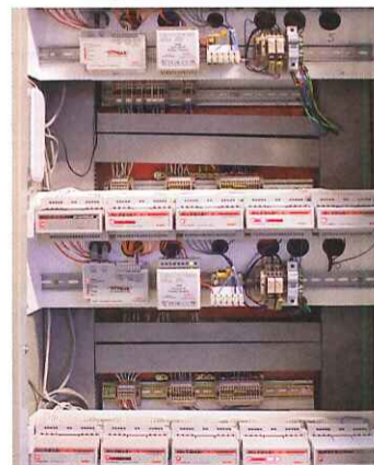
SNABBKOPPLAD. Styrningen är moduluppbyggd och monteras på några timmar.
